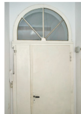
Bleibt erhalten: Der Bogen über der Eingangstür ist alt.
