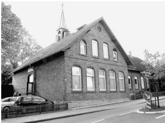
Ortsprägender Backsteinbau: Die alte Dorfschule an der Deppendorfer Straße ist ein Blickfang.
