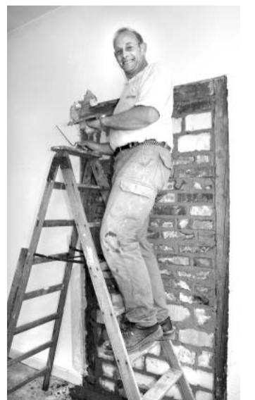
Fleißig: Jürgen Hilbers verputzt die Wand in der Wohnung.
