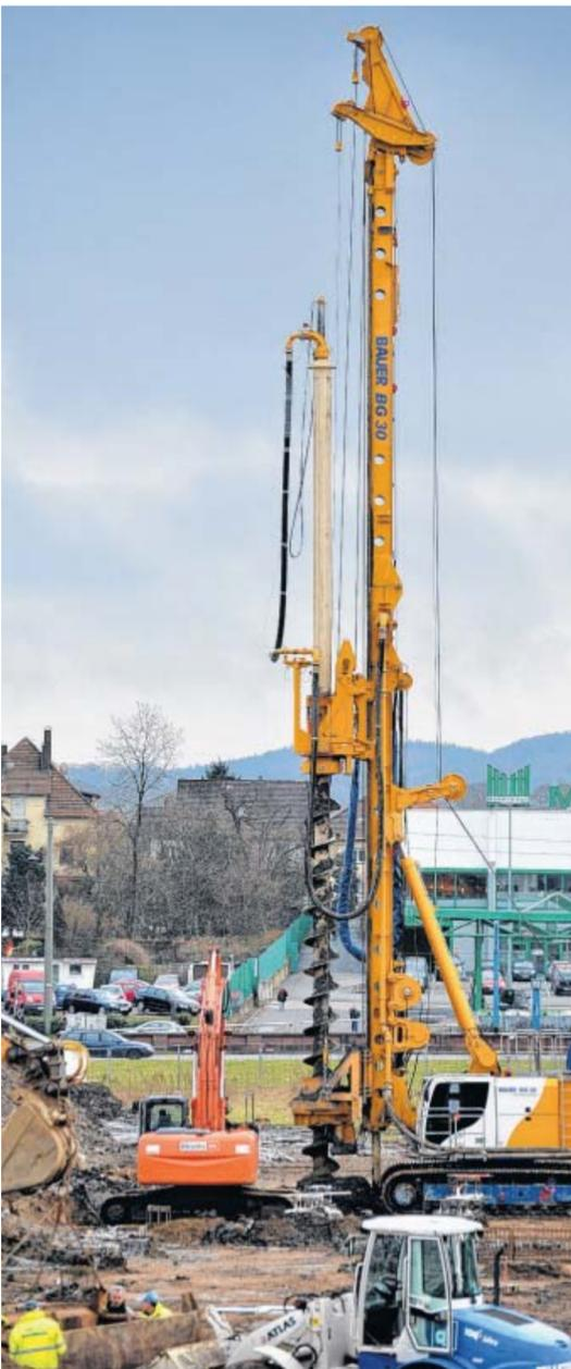
Hier baut Oetker: Auch hier ist der Boden schlammig, also muss das Drehbohrgerät ran. 160 Pfähle werden gesetzt. FOTOS: ANDREAS FRÜCHT
