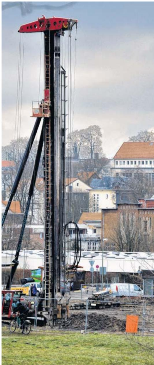
Hier entsteht die Brockensammlung: Da an der Tonkuhle der Untergrund nicht ausreichend tragfähig ist, setzt das Riesengerät 30 Pfähle.
